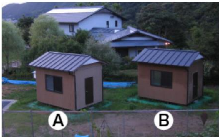
左：A 外壁（シラス外装材） 右：B 外壁（シラス外装材）に打ち水
